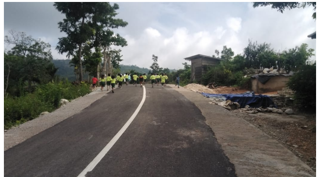
Die fertiggestellte Zufahrt im Dezember.
