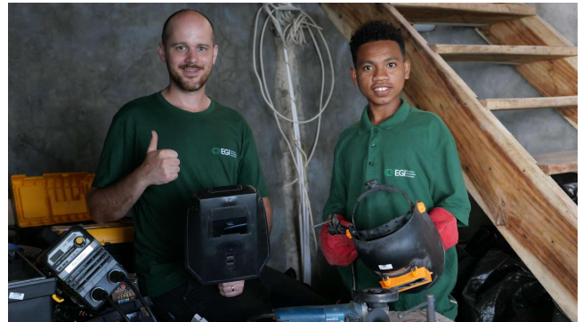
Mitarbeitende bereiten Geräte für die Arbeit am Bauprojekt vor.
