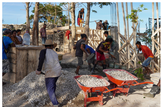
Betonarbeiten am ersten Schulgebäude. Vieles entsteht in Handarbeit.
