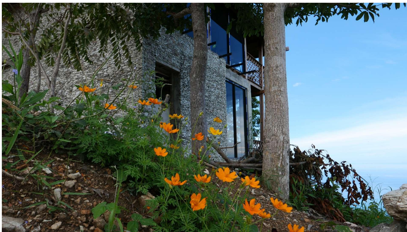
Die Fassade des Schulgebäudes, wie sie bereits Ende 2023 bestand.
