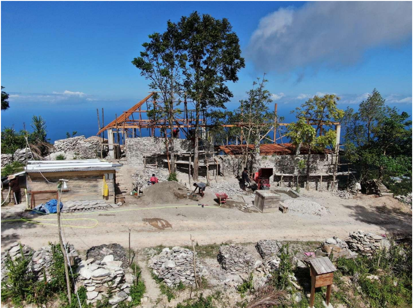
Der Rohbau im August 2023. Das Dach wurde noch im selben Jahr fertiggestellt.
